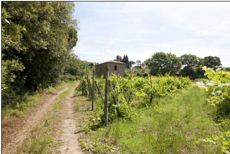
Vista Fabbricato "C"
