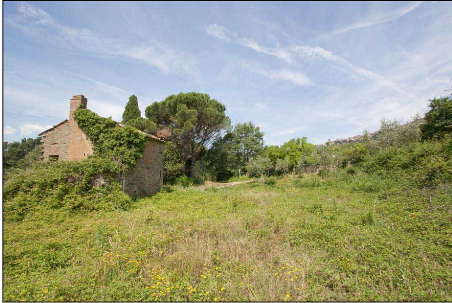
Vista Fabbricato "C"
